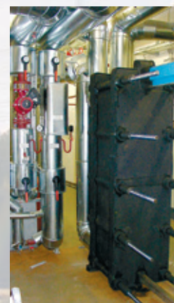
Центральный охладитель в охладительных системах
